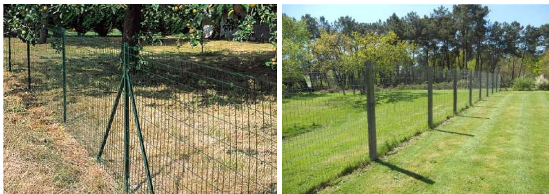
Grillage métallique. Mailles électro-soudées carrées ou rectangulaires, hauteur = 1.60m, teinte grise ou galvanisé. Autorisée en limite latérale et en fond de parcelle sauf celles donnant sur le domaine public (lisière par exemple).
