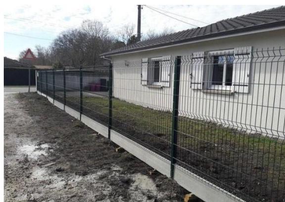
Soubassements de clôture et murets maçonnés
